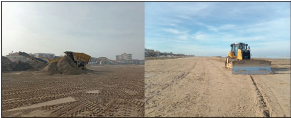
Figura 2. Mezzi meccanici al lavoro in spiaggia a Senigallia (AN), febbraio 2023.
